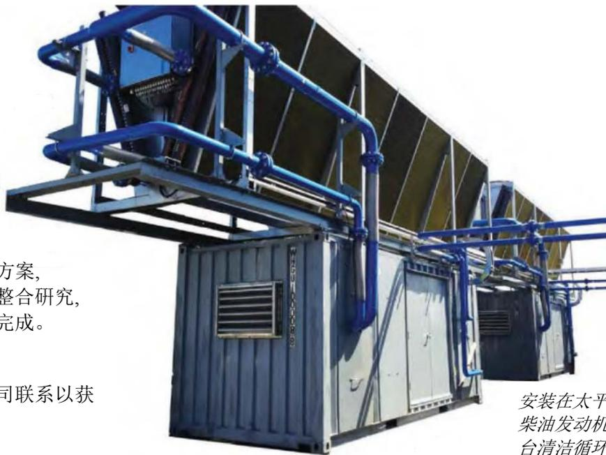
安装在太平洋岛屿柴油发动机上的 2 台清洁循环装置。
